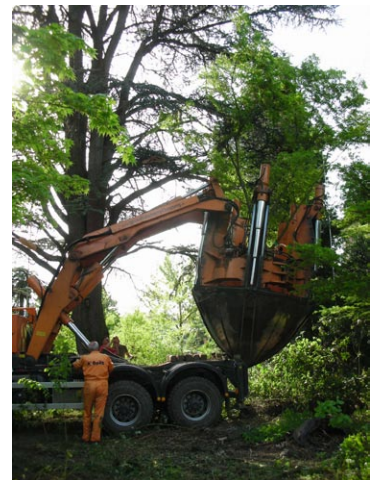
Ausheben an altem Standort
