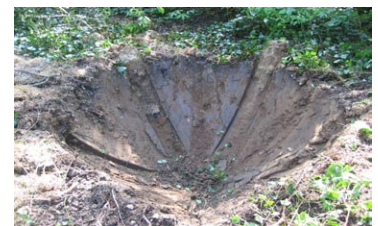
Aushub an neuem Standort
